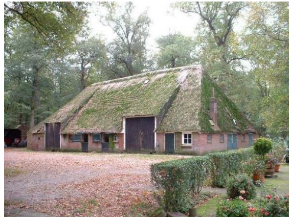
Staldeur zonder kozijn, deze constructie moet behouden blijven. Wel kan aan de binnenzijde achter de binnenmuur een kozijn geplaatst worden. Als de staldeur dan openstaat is het kozijn door de detaillering, materiaal- en kleurgebruik nauwelijks te zien. Ook het uiterlijk van de stalramen moet behouden blijven.
