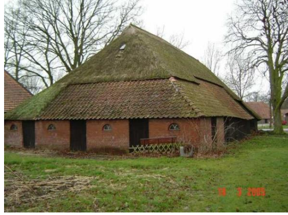
Staldeur zonder kozijn, deze constructie moet behouden blijven. Wel kan aan de binnenzijde achter de binnenmuur een kozijn geplaatst worden. Als de staldeur dan openstaat is het kozijn door de detaillering, materiaal- en kleurgebruik nauwelijks te zien. Ook het uiterlijk van de stalramen moet behouden blijven.
