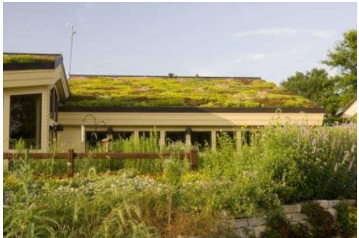
Figuur 13 Het groene dak van de Heeckerenschool in Goor, foto van Goorsnieuws.
