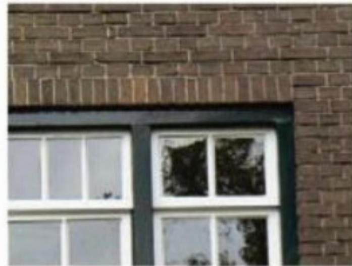
Overgang: houten kozijn, diepe nege
