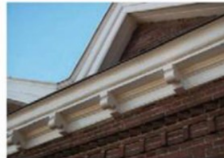
Delden, zorgvuldige en verfijnde detaillering
