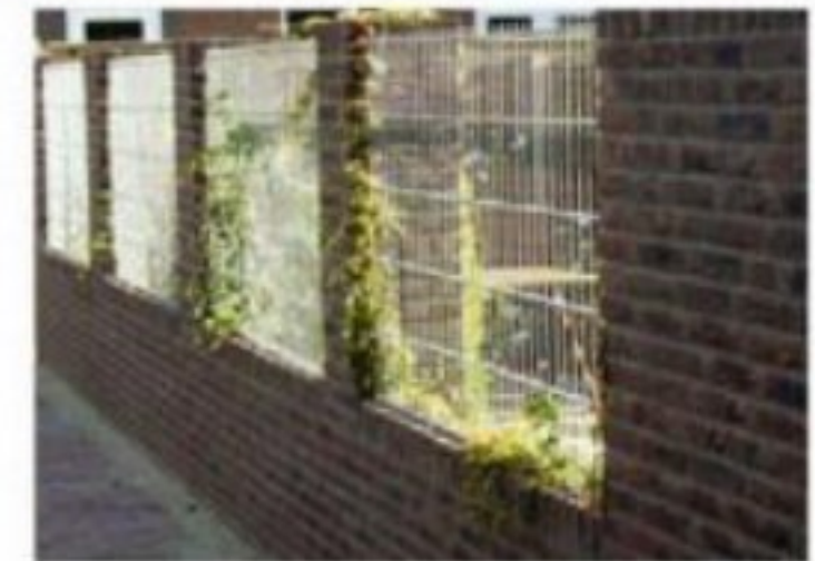
Hoge erfafscheiding in de architectuur van de woning
