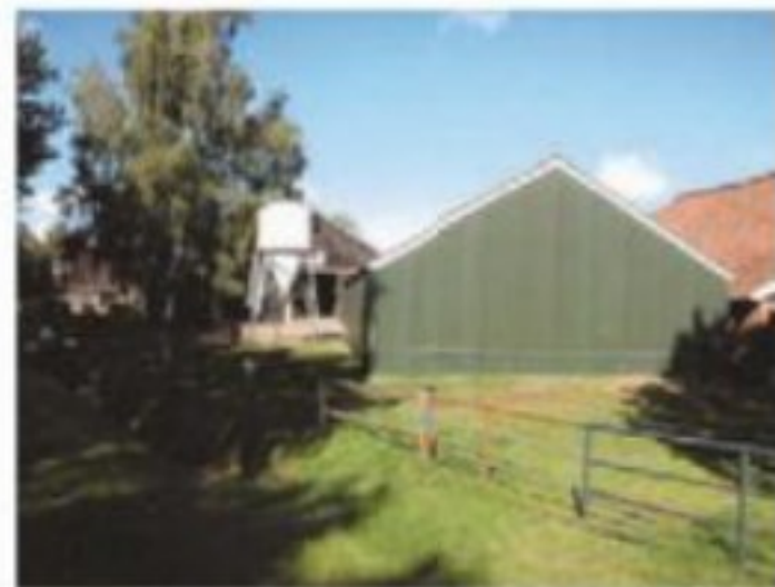
Nieuwe schuur van profielplaat
